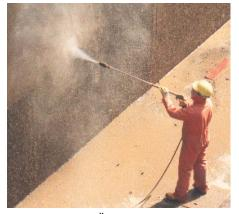
Der TURBOFRÄSER – die Kombi-Düse aus Punkt- und Flachstrahl – entfernt Schmutz und Farbe schnell und effektiv.
